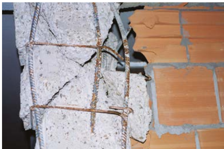
Foto 1 e 2. Dissesti a seguito di sisma in un edificio a Boniferno (CB). [Per gentile concessione del prof. N. Nisticò]
