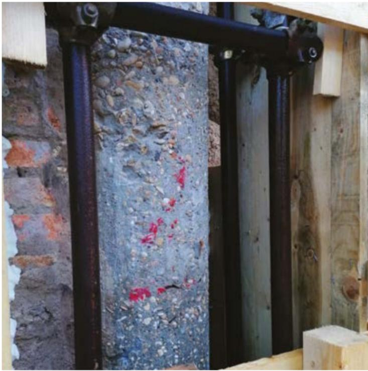
crisi della struttura soggetta a sollecitazioni sismiche avviene per formazione di cerniera plastica nel pilastro.
