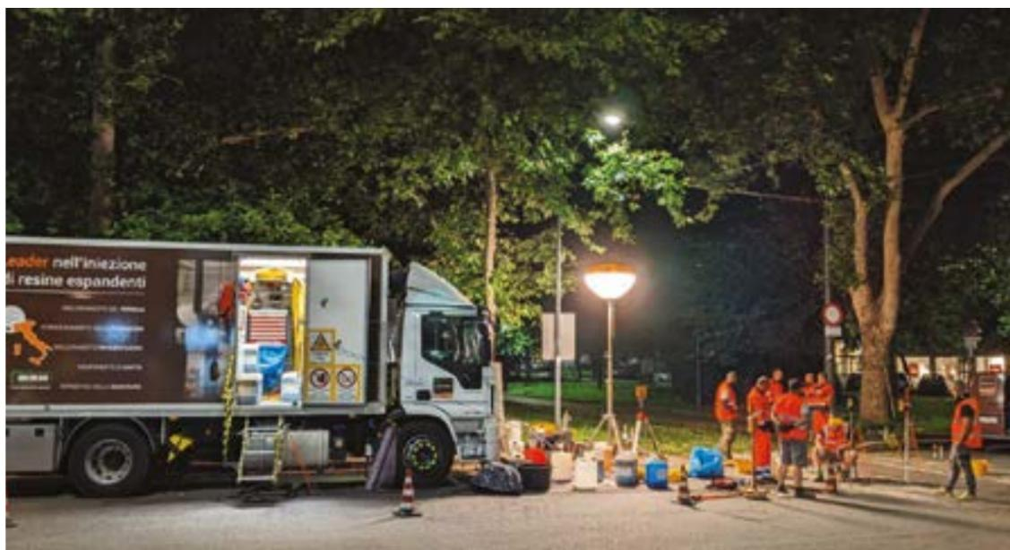
dei binari tramite iniezioni di resine poliuretatiche espandenti. Questa tecnica ha il vantaggio di evitare gli scavi: non è infatti necessario rimuovere né l'asfalto né il materiale di sottofondo esistente.
