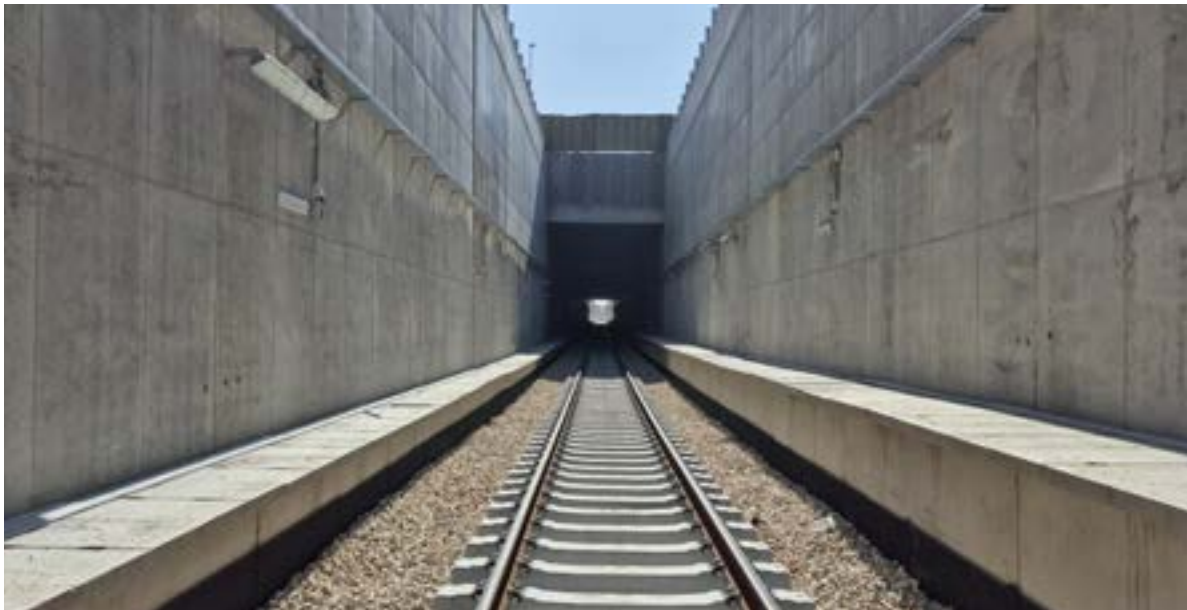
Galleria Artificiale ferroviaria, Andria (BAT)
