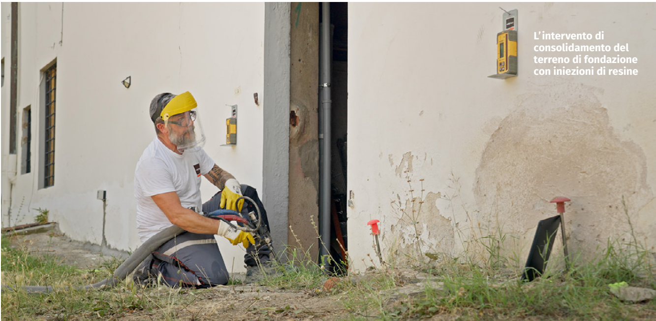
Fessurimetri biassiali brevettati sulle lesioni principali per il monitoraggio post-intervento
