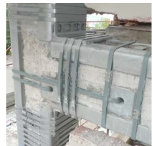
Fig. 4. DIS-CAM®: Sistema di gerarchizzazione dissipativa trave-pilastro
