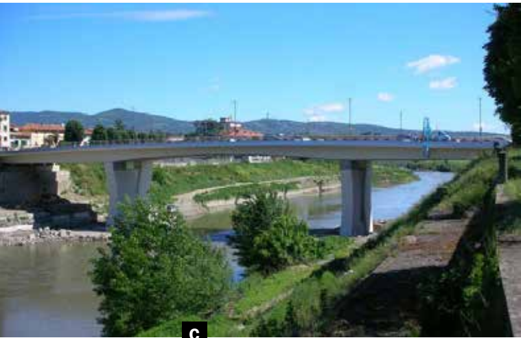
Vista generale dell'attraversamento
