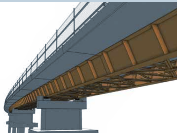
Viadotto in struttura mista acciaio - calcestruzzo
