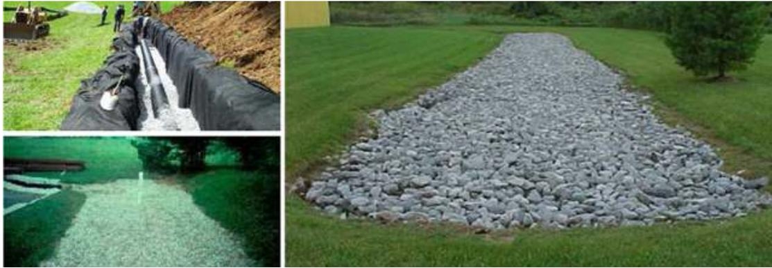
**Figura 4** - Alcune fasi della realizzazione di una trincea di infiltrazione.
