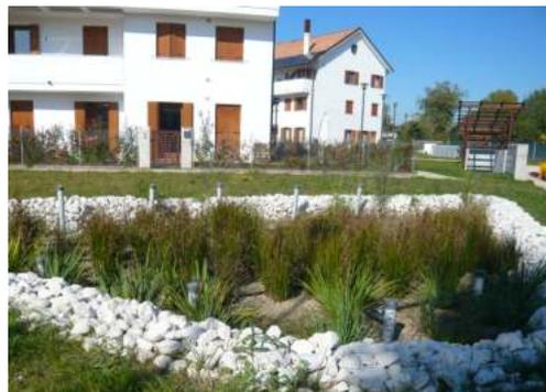
**Figura 1** - Rain Garden che tratta le acque di pioggia provenienti dai tetti e dai piazzali di un edificio a Preganziol (VE) per poi inviarle a cisterna di accumulo.
