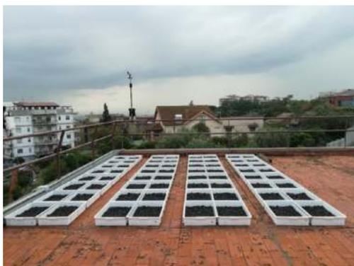
**Figura 1** - Tetto blu di tipo modulare realizzato su un edificio della Cittadella universitaria di Catania (Campisano et al., 2021).
