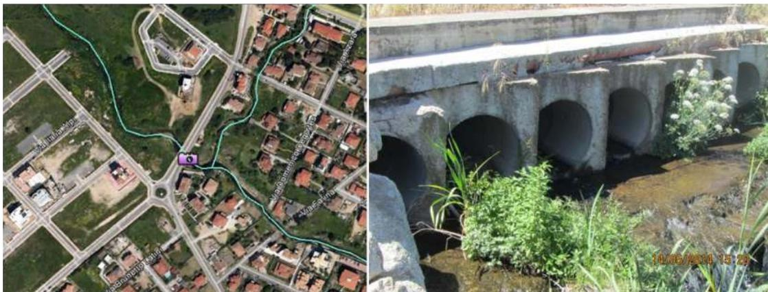
**Figura 2** - Attraversamento sul riu san Nicola, con riduzione di sezione (via Galvani).
