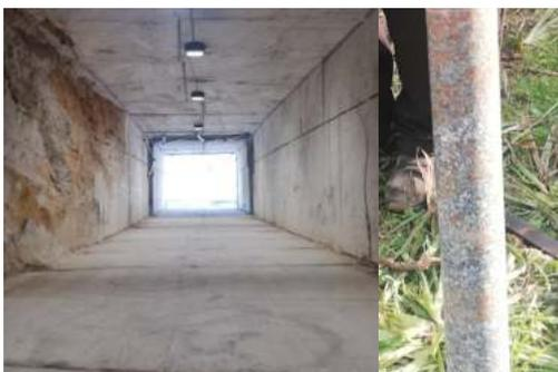
Figura 6 - Esempio di galleria non rivestita scavata in roccia con tecnologie da taglio.
