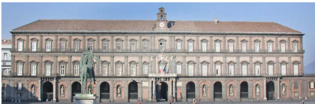
Figura 5 - Palazzo Reale di Napoli: costruito a partire dall'inizio del 17° secolo su progetto di Domenico Fontana, aveva inizialmente il portico con tutti gli archi aperti. Per il manifestarsi di dissesti alle fondazioni dei piedritti di questi archi, più di un secolo dopo Luigi Vanvitelli progettò un intervento di consolidamento consistente nella chiusura di molti archi e con l'inserimento di nicchie e statue.
