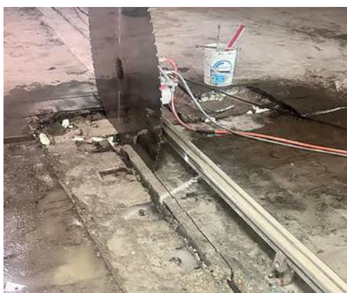
Figura 12 - Fotografia scattata durante il taglio dei solai per implementazione di giunti
