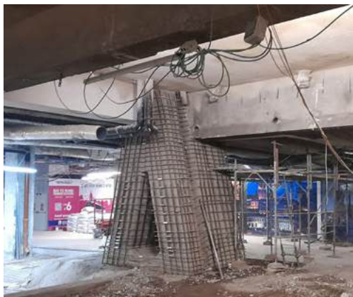
Figura 11 - Immagine dei lavori per il ringrosso dei pilastri in c.a.
