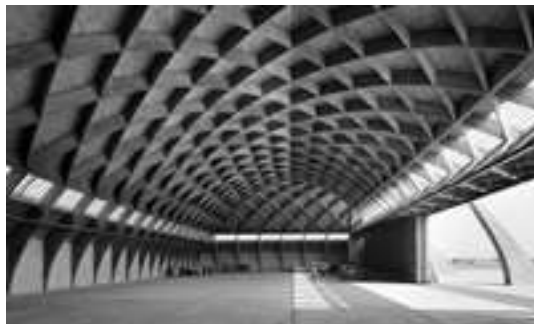
Figura 2. Le autorimesse di Orvieto (Nervi 1935) in calcestruzzo armato
