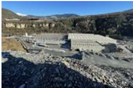
Figura 4. BBT - un esempio di economia circolare: rocce dagli scavi per la fabbricazione dei conci in cls
