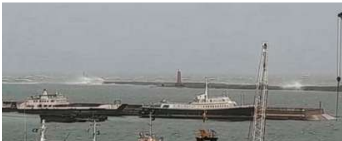
Figura 1. Tracimazione sulla diga foranea del porto di Napoli durante una mareggiata. La struttura non crolla, ma la funzione portuale risulta compromessa: è il caso tipico di arresto operativo (Foto: M. Calabrese).
