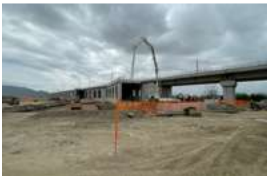
Figura 5. AV Napoli-Bari in costruzione
