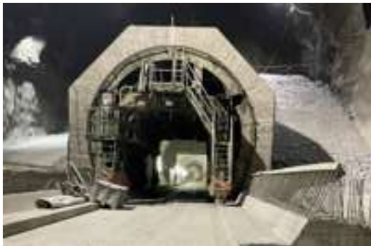
Figura 3. La Galleria di Base del Brennero in fase di scavo
